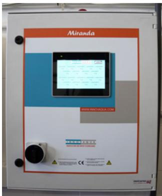
**Miranda ACB** (Cuadro de control) incluye un PLC industrial con pantalla táctil. Utilizando las sondas apropiadas y comunicándose con los controladores, puede leer distintos parámetros (pH, oxígeno, temperatura, etc.), y, en su caso, actuar sobre los dispositivos (bombas, válvulas, etc.) encargados de mantener sus niveles dentro de los rangos deseados.
